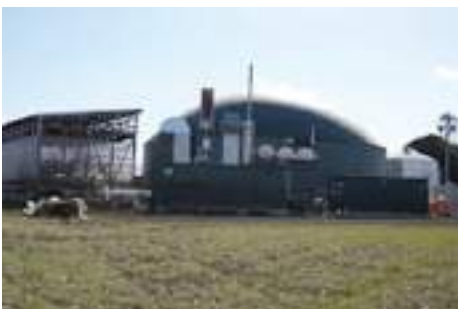
バイオガスによる発電プラント
