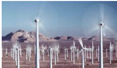
1987 年、カリフォルニアに建設された風力発電所。
