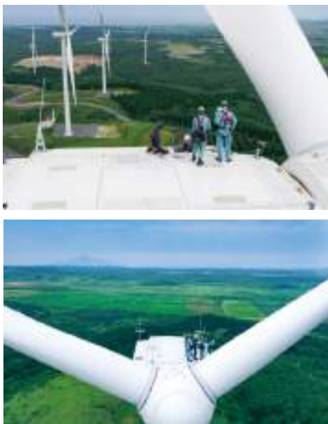
風車のメンテナンスを行っている様子
