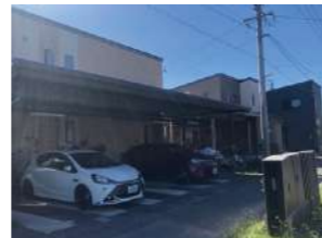
外国人世帯のために造成した住宅団地
